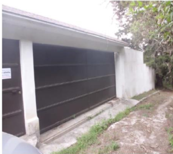
PORTÓN Y PUERTA DE INGRESO
