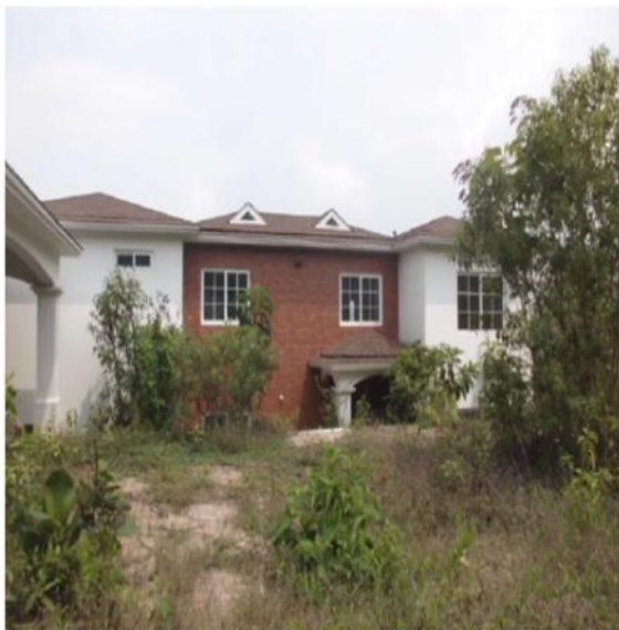
VISTA GENERAL DE LA CONSTRUCCIÓN
