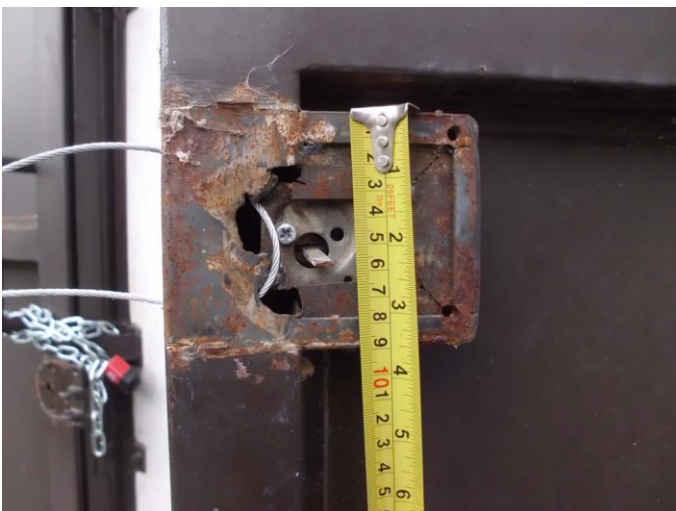
CHAPA DE PUERTA DE INGRESO ARRANCADA
