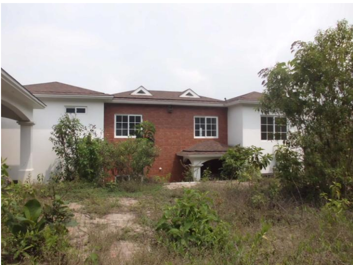
VISTA GENERAL DE LA CONSTRUCCIÓN
