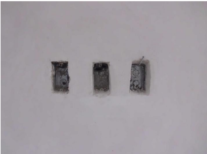
CAJAS RECTANGULARES SIN ARTEFACTOS NI CABLEADO
