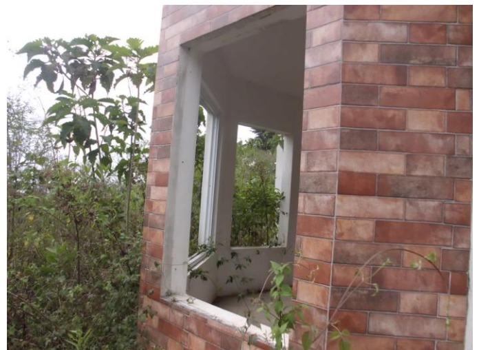
VISTA FACHALETA EN PAREDES
