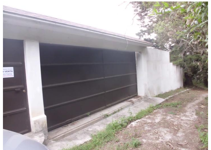
PORTÓN Y PUERTA DE INGRESO
