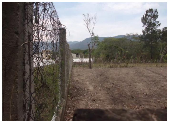
VISTA GENERAL DEL MURO PERIMETRAL
