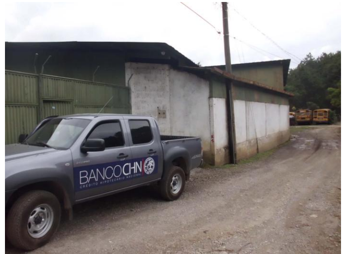
VISTA DEL FRENTE DEL INMUEBLE
