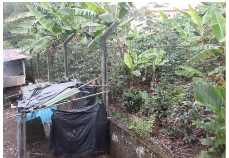
VISTA DEL MURO PERIMETRAL CON MALLA
