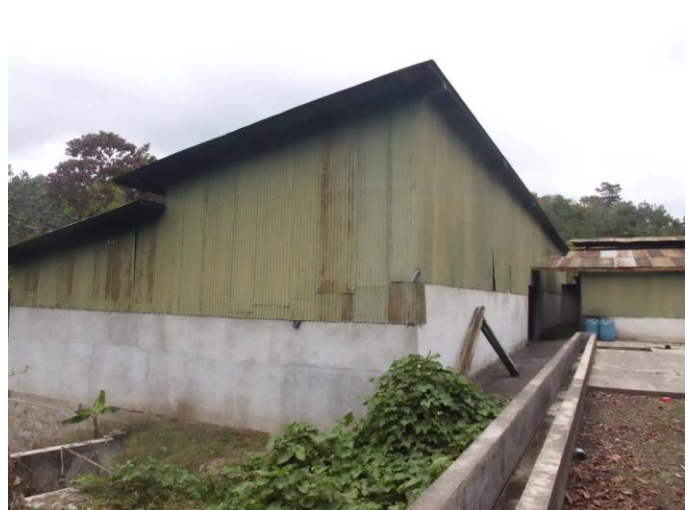
VISTA GENERAL DE LAS BODEGAS
