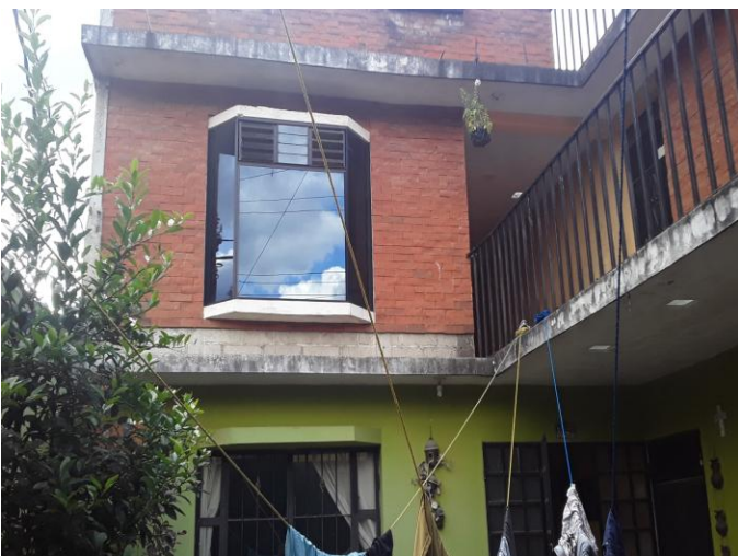
VISTA DEL SEGUNDO NIVEL
