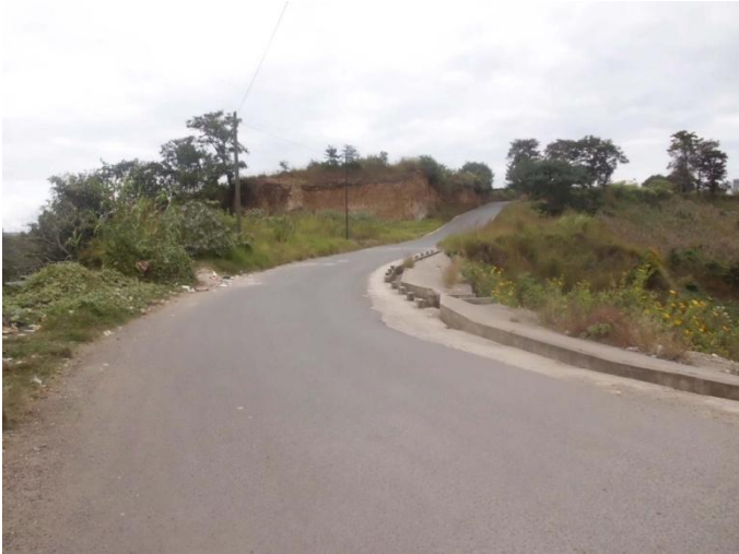
CALLE DE ACCESO AL INMUEBLE
