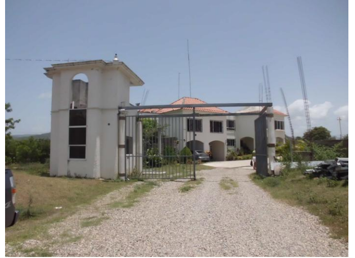
VISTA INGRESO AL RESIDENCIAL
