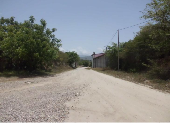
CAMINO DESDE LA CALLE PRINCIPAL
