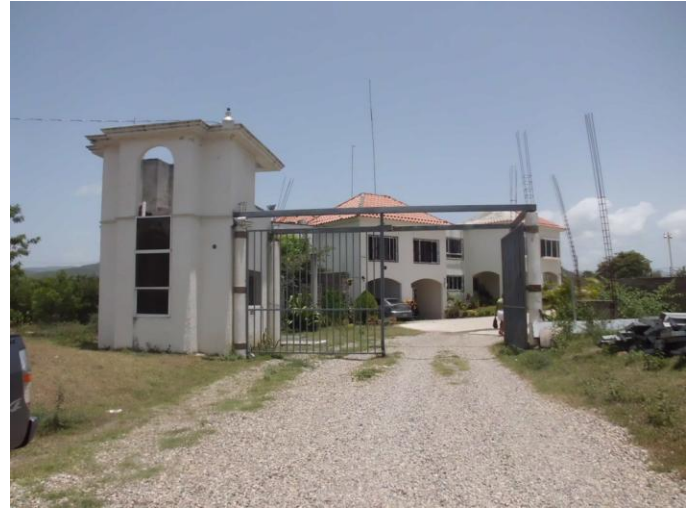
VISTA INGRESO AL RESIDENCIAL
