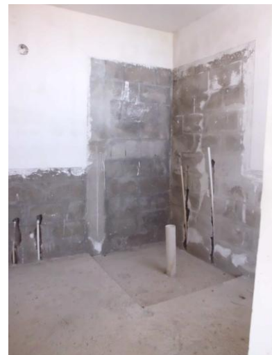
VISTA AREA DE BAÑO
